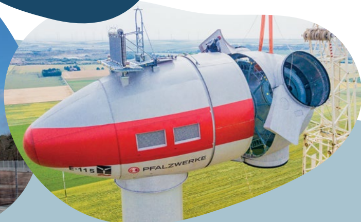
Impressionen vom Bau Windpark Rüssinger Berg
